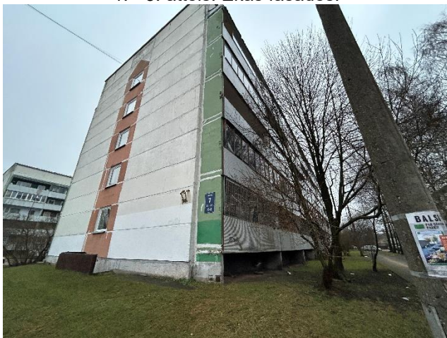
1. - 3. attēls. Ēkas fasādes.
